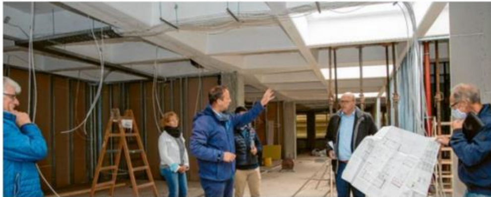
Stadtbaumeister Thomas Wanner stellte den Schulverbandsmitgliedern vor, wie weit die Arbeiten im Erdgeschoss im Fachklassentrakt sind. Foto: Brigitte Bunk
